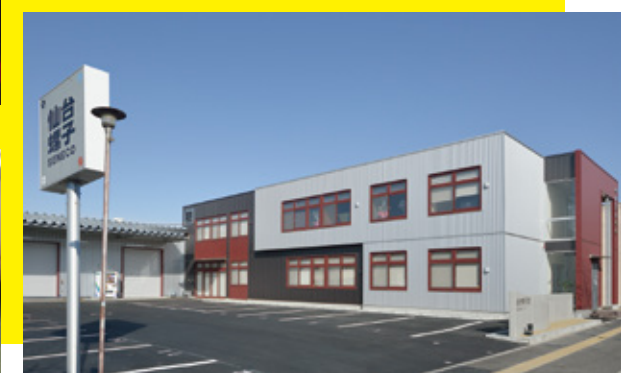
2013年3月 仙台営業所改築工事竣工
