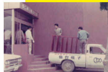
1976年 完成した社屋での作業風景
